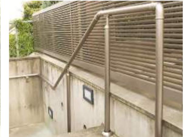
階段などの傾斜部は、自在エルボにて90度~170度までの自由な角度に調整が可能。また、支柱と手すりパイプの接続も、連結ボルトが見えない角度調整可能な自立型可動ブラケットを使用します。支柱と手すりパイプが同じ径ですので、スマートな外観です。さらに手すりの端部を自在エルボで支柱と連結することにより、スッキリとしたコーナー部を演出することができます。安心と安全を美しくどこまでもつなぐアルホージョです。
