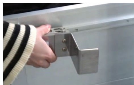
①設置金具をレールに取り付ける
