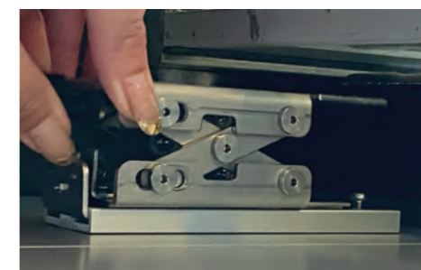
②プレートを伸ばし自動ドアの柱に幅を合わせる
