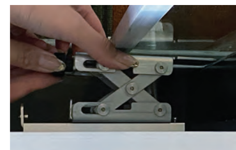
③自動ドアの隙間にプレートを挟みネジを回して固定 ※左右2か所に固定プレートがあります 設置金具は、商品を適正に固定させるものであり、 止水パッキンを押潰す機能はございません。 無理に締め付けた場合、部品が変形する場合がございます。
