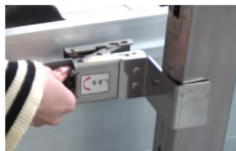
③ヒンジドアの隙間にプレートを挟みネジを回して固定 ※上下2か所に固定プレートがあります 設置金具は、商品を適正に固定させるものであり、 止水パッキンを押潰す機能はございません。 無理に締め付けた場合、部品が変形する場合がございます。
