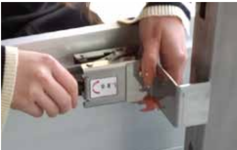
②ネジを回してバネを緩めプレート伸ばし ヒンジドアの側面に幅を合わせる
