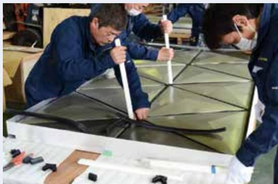
霧吹きで取付部を濡らしてから押し込み用の棒を使って目地ゴムをパネルの隙間に取り付けます。
